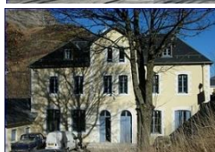
La résidence Capet à Barèges – 11 logts- (1963).
