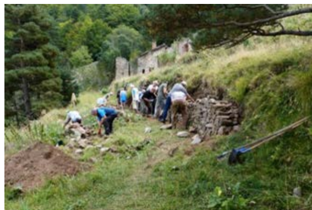
Exemple d'atelier participatif Remontage de murets de pierres sèches au grand Site du Canigò https://www.canigo-grandsite.fr/content/mission-accomplie-sur-le-pla-guillem
