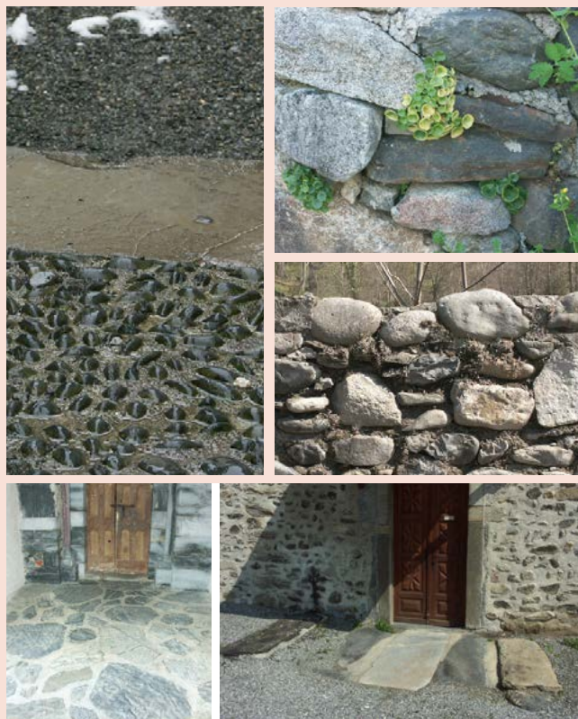
Utilisation des galets dans l'architecture vernaculaire et les espaces publics / source étude Gouyou Beauchamps - Barsacq - 2008
